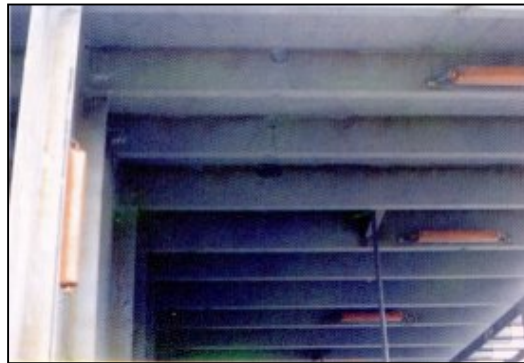
..... figuur 3 Plaatsing opofferingsanodes in ballasttanks
